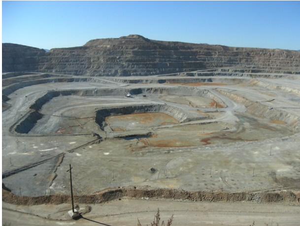
写真 1 展望台からエルデネット鉱山露天掘り全容を見る。
