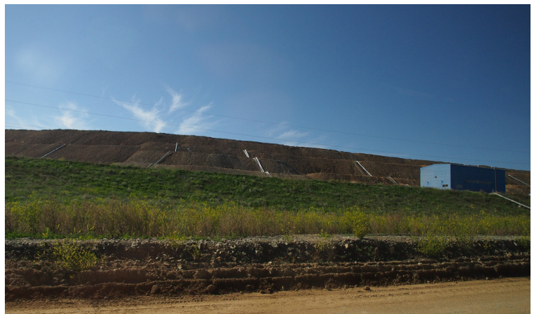
写真 4 ヒープリーチングのプラントと積み上げられた低品位の鉱石。
